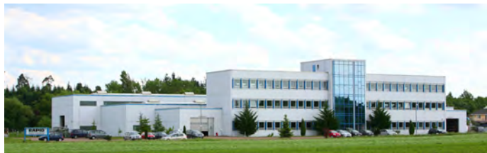
RAPID-Zentrale in Grosselfingen
