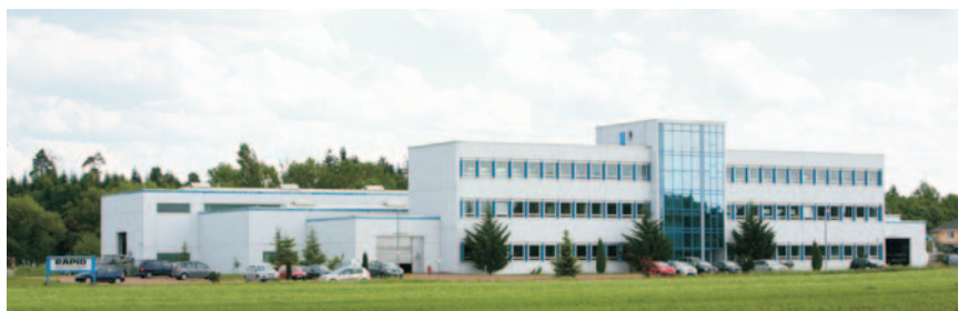
RAPID-Zentrale in Grosselfingen
